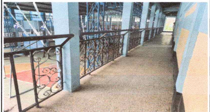
Foto 8: MANTENIMIENTO Y APLICACIÓN DE PINTURA ANTICORROSIVA R15 DE CELCO EN BARANDAS DE METAL
