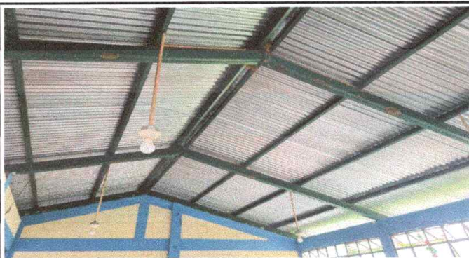
Foto 3: MANTENIMIENTO A ESTRUCTURA DE METAL, LIJADO PULIDO, APLICACIÓN DE DOS MANOS DE PINTURA ANTICORROSIVA MARCA CELCO R15
