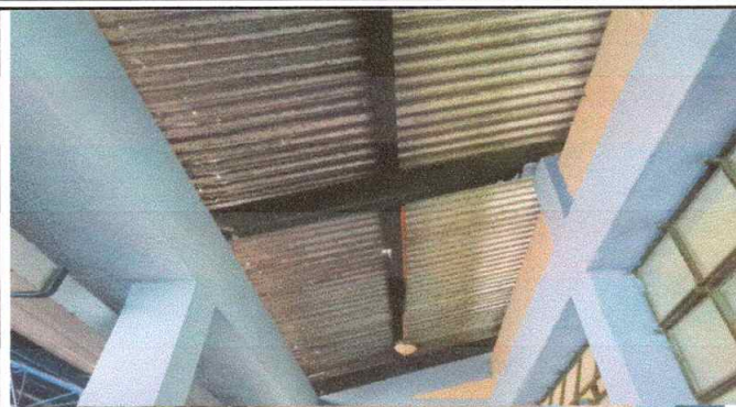
Foto 1: SUSTITUCIÓN LÁMINA TROQUELADA DE ALUZINC CALIBRE 26, MARCA MAXALUM.
