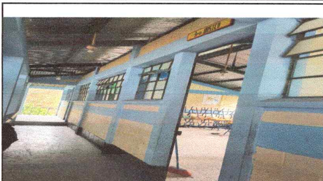
Foto 2: SUSTITUCIÓN LÁMINA TROQUELADA DE ALUZINC CALIBRE 26, MARCA MAXALUM.
