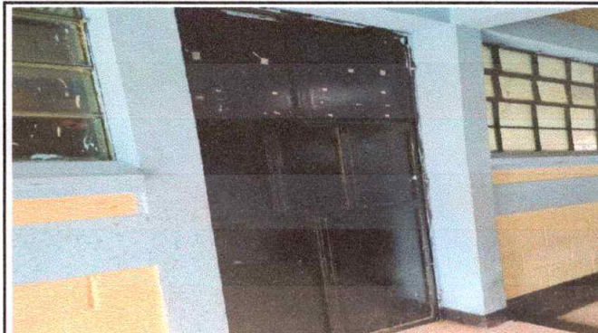
Foto 4: MANTENIMIENTO DE PUERTA, ENDEREZADO, SOLDADURA Y PINTURA ANTICORROSIVA R15 DE CELCO
