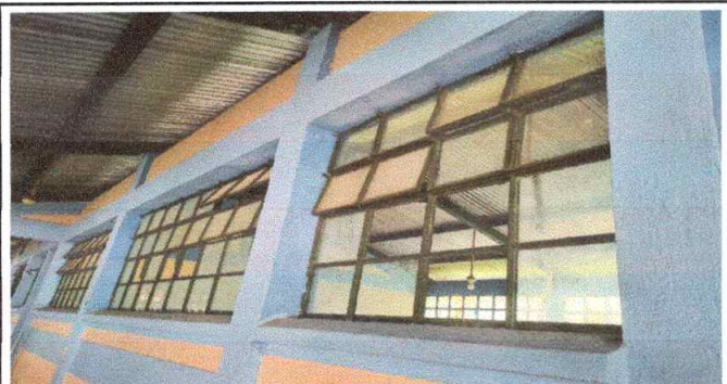
Foto 5: SUSTITUCIÓN DE VIDRIOS DE 24 POR 29 CENTÍMETROS, DE 5 MILÍMETROS
