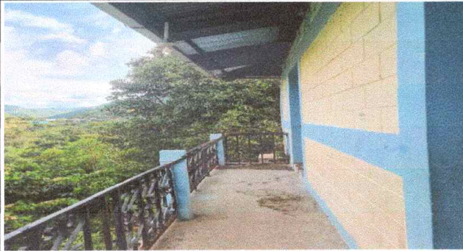
Foto 7: SUSTITUCIÓN DE BARANDA DE METAL
